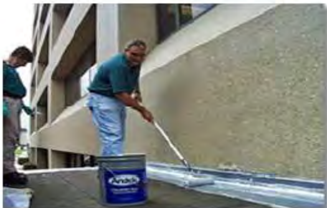
تصویر شماره ۳: اجرای عایق مایع ویسکوز بر روی بام
